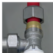
Placer l'adaptateur dans le robinet.
