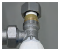
Placer l'adaptateur dans le robinet.
