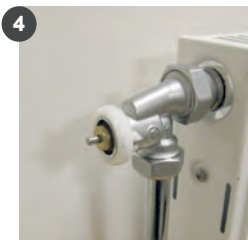
4 Placez la bague en plastique fourni avec la clef.
