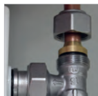
Placez l'adaptateur dans le robinet.
