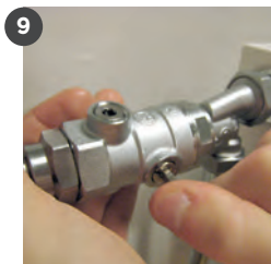
9 Refermez la purge du dessus et ouvrez la vanne sur le côté.
