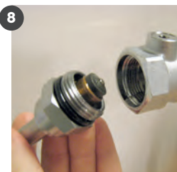
8 Dévissez la partie antérieure de la clef puis changez le mécanisme et revisser là.
