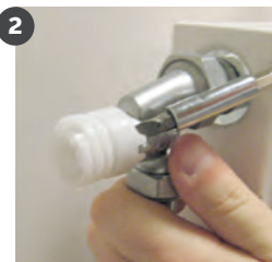
2 Enlevez la bague en plastique blanche à l'aide d'un tournevis.
